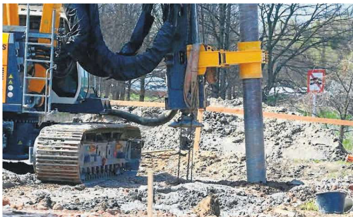
Rozpoczęto wiercenie ponad tysiąca otworów o głębokości od 6 do 9 metrów, pod betonowe pale wzmacniające grunt na którym zbudowane zostaną podpory wiaduktów i mostów
